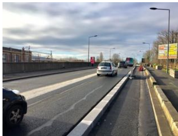
Stains - av. Aristide Briand- RD 901
